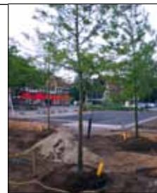
Mit Unterflurverankerung gesichert
